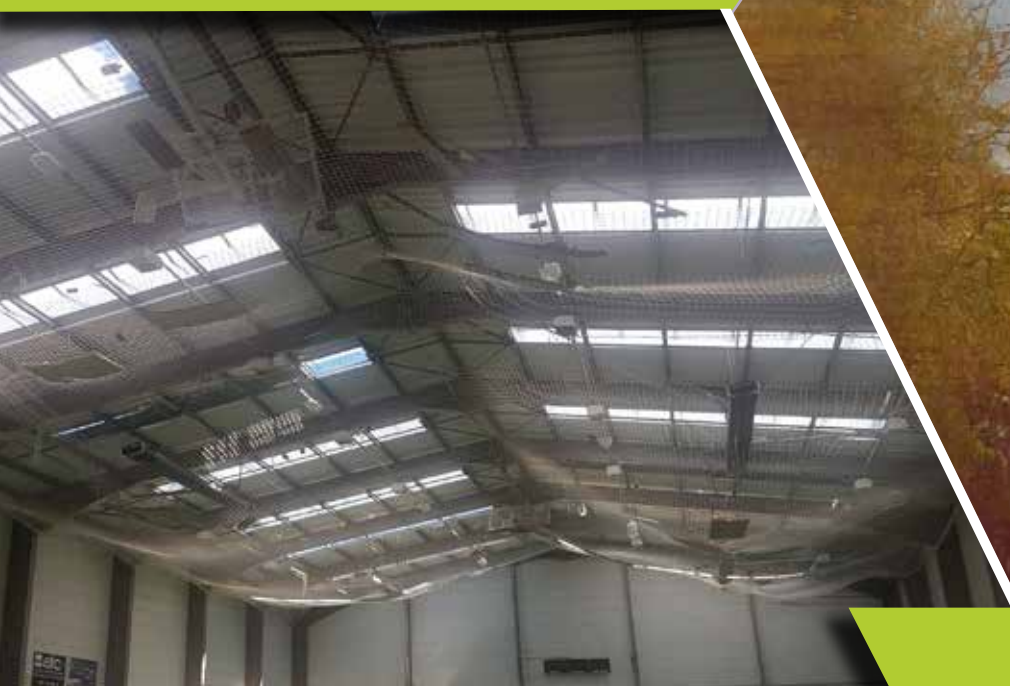
Une nouvelle toiture pour le gymnase,
