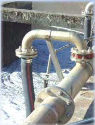
Ensuite, les rampes d'insufflation d'air ont été totalement remplacées. Cet élément, indispensable dans le traitement des eaux usées, permet un développement bactérien accru. Les techniciens ont également procédé à la reprise de l'ensemble des canalisations en inox acheminant l'air vers les insuffleurs.
