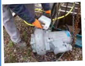
Afin d'assurer la longévité des pompes de relevage des eaux usées de la station d'épuration de Malmont, les agents des services techniques et un artisan saint-justaire spécialisé dans la maintenance de ce type d'appareil ont procédé à la dépose des pompes, à la vérification de l'étanchéité de leurs joints et à leur graissage, avant de les remettre en place.
