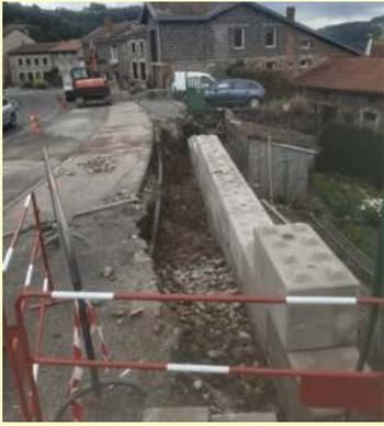
Réfection d'un mur de soutènement : ce mur s'était partiellement écroulé rue du Rossignol, avec un risque de dommage sur le trottoir et la chaussée attenante. Les travaux ont permis de sécuriser et consolider les lieux avec des blocs de béton "façon Lego" de plus d'une tonne chacun.
