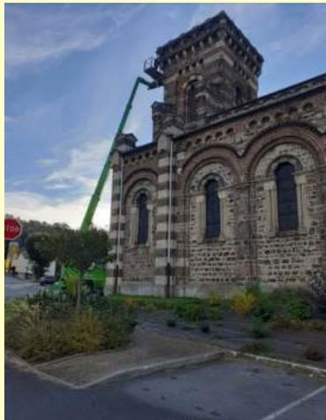
Rénovation du clocher et de la façade de l'église par le remplacement des briques cassées et déjointées
